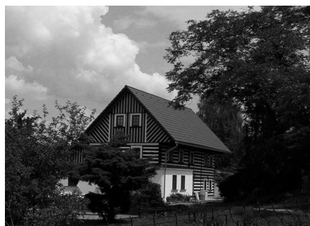
Obnovená roubenka na Křenově
