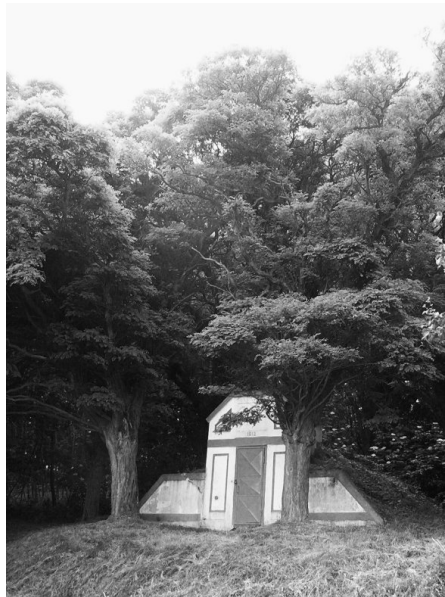
Vodárna nad Křenovem
