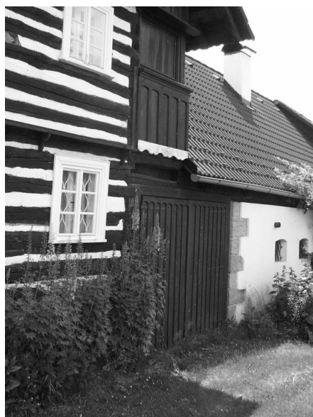
Detail roubeného dome na Křenově
